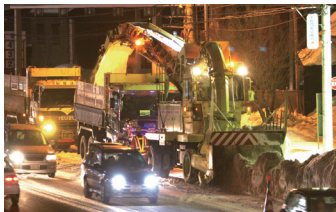
●一車線積込作業(縦列)
