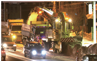
●一車線積込作業（縦列）
