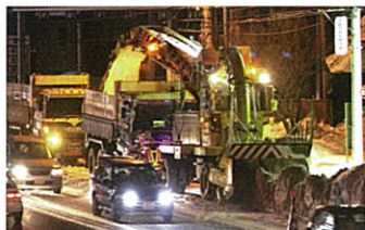
●一車線積込作業（縦列）
