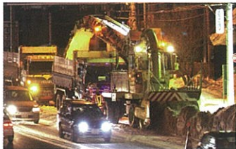
●一車線積込作業（縦列）
